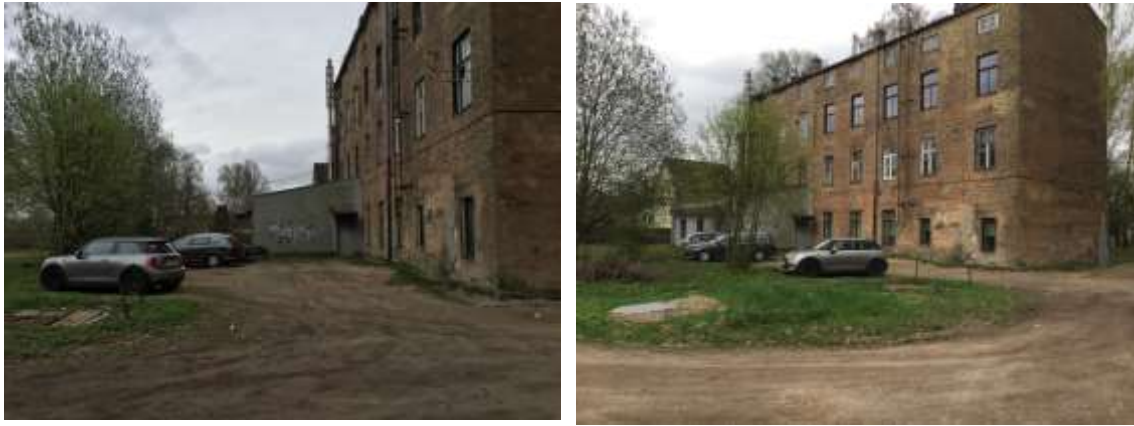
3.6.attēls. Autonovietnes pie dzīvojamās mājas Bauskas ielā 134A, Rīgā
