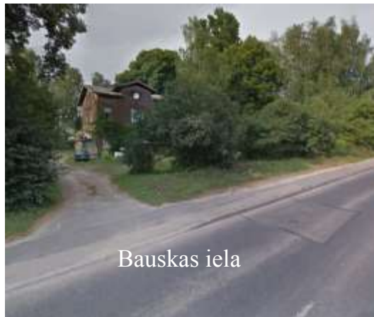
3.4.attēls. Iebrauktuve no Bauskas ielas pie dzīvojamās mājas Bauskas ielā 134, Rīgā Datu avots: https://www.google.com/maps
